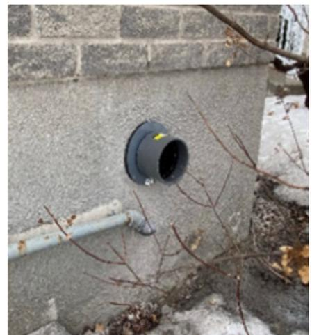
Figure 3 : Système RadonX utilisé pour un système d'atténuation active du radon (niveau 3)
