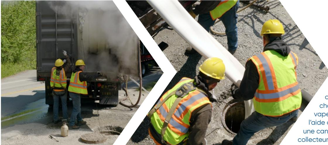
La gaine NovaForm est chauffée et conditionnée sur le chantier avec de la vapeur, puis déroulée à l'aide d'un treuil puissant dans une canalisation d'égout ou un collecteur pluvial existants.
