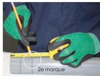
Faire une **2e marque** sur le DE du tuyau. La distance entre la seconde marque et la première marque doit être la même que la profondeur d'emboîture du raccord.
