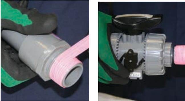
La pression nominale d'un tuyau de classe T fileté doit être réduite à 180 psi à 73 °F.
