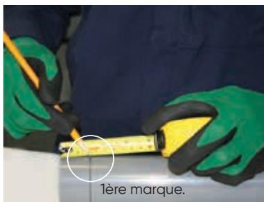
Marquer cette distance (profondeur d'emboîture du raccord) sur le DE du tuyau; **1ère marque.**
