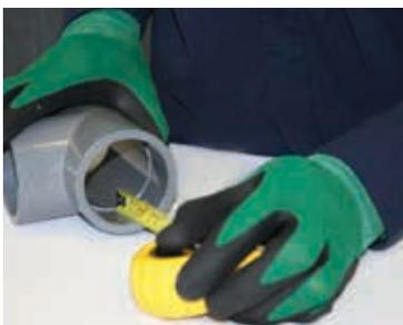
Mesurer la profondeur de l'emboîture du raccord.
