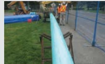
Le PVC fusionné a été retenu car il perturbe peu ces terres et forêts sous protection fédérale. Également à cause des contraintes liées au contrôle de la circulation.
