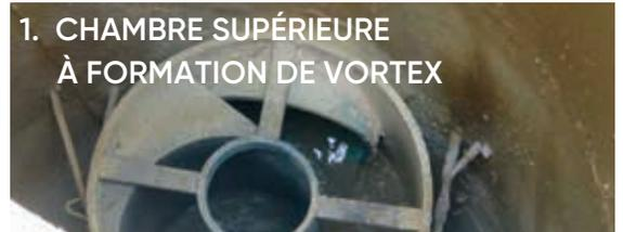
Les eaux usées s'écoulent dans la chambre supérieure à formation de vortex qui dirige l'écoulement autour d'un canal de rayon décroissant. En même temps, le canal à vortex ayant une pente descendante accélère les eaux usées jusqu'à une vitesse supercritique.
