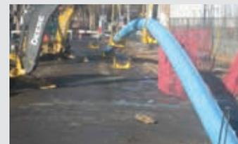
Les tuyaux Brute Fusionnée DR25 ont été sélectionnés pour leurs caractéristiques hydrauliques optimales dans le cas de ce tubage.
