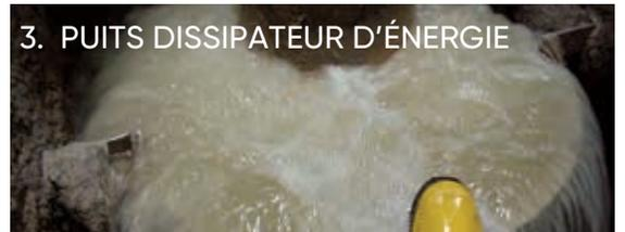
La sortie est submergée dans le puits dissipateur d'énergie, situé au fond de la colonne. L'air et les gaz aspirés vers le bas dans le « noyau d'air central » sont ramenés de force dans les eaux usées et entraînés avec celles-ci. Il s'ensuit une augmentation substantielle de la concentration en oxygène dissous et les composés odorants sont rapidement oxydés.
