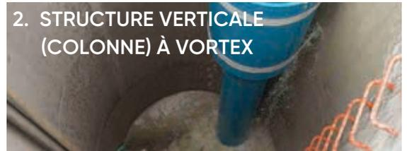
Une fois les eaux usées dans le puits de descente de plus petit diamètre, la vitesse et les forces centrifuges engendrées repoussent ces eaux contre la paroi intérieure du puits de descente. L'écoulement en hélice crée un noyau d'air central à pression négative, entraînant les gaz contenus dans l'air dans le puits dissipateur d'énergie.
