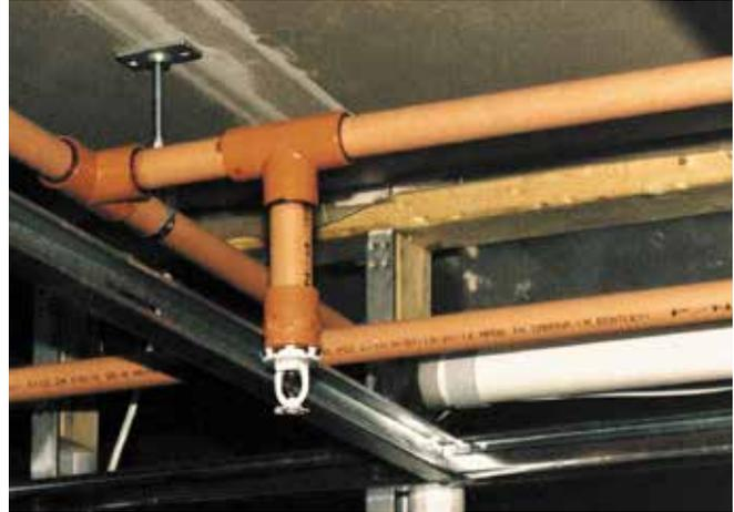
Les normes NFPA 13R et 13D permettent cependant de ne pas prévoir d'extincteurs automatiques dans un espace combustible dissimulé et il est possible d'installer des tuyaux et raccords BlazeMaster dans ces endroits, pour la protection de locaux à usage d'habitation selon ces normes.
