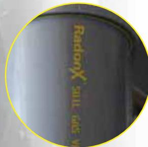
**C.** Les lignes jaunes imprimées se trouvent des deux côtés du tuyau (à 180 degrés l'une de l'autre) et indiquent le type de matériau, l'utilisation prévue (en-dessous ou au-dessus du sol) et la conformité aux normes.
