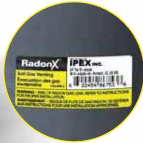
**A.** Les étiquettes d'avertissement sur les raccords ne servent pas seulement à faciliter l'identification, mais encouragent également les installateurs à utiliser des méthodes de raccordement adéquates.
