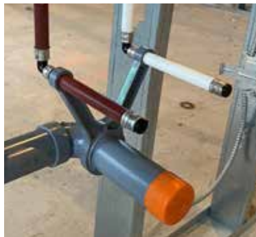
Installation des conduites d'eau d'un Système XFR
