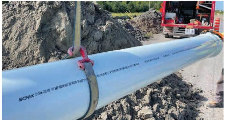
Mise à l'essai du tuyau sur un tronçon d'un kilomètre pour en garantir l'étanchéité avant de passer au suivant.
