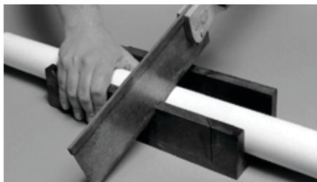
On peut également couper les tuyaux en matière plastique à l'aide de coupe-tubes prévus à cet effet; certains de ces outils forment cependant un bourrelet en surépaisseur à l'extrémité du tuyau. Ôter ce bourrelet avec une lime ou un alésoir, afin d'éviter le raclage de la colle au moment de l'insertion du tuyau dans le raccord.
