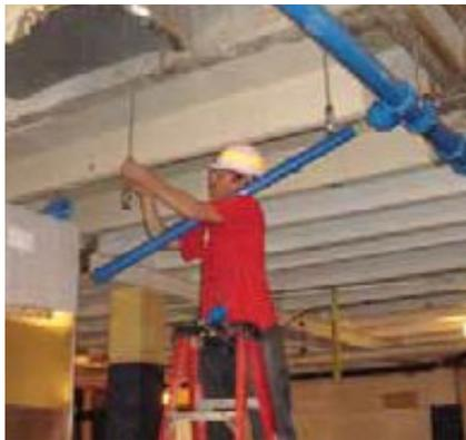
Le distributeur local Plenumline recommanda le système d'évacuation d'acides résiduels assemblé par joints mécaniques Plenumline<sup>MC</sup> en FR-PVDF d'IPEX. Satisfaisant aux exigences rigoureuses de la norme ASTM E84, avec un indice de propagation de la flamme de 5 et un indice de dégagement des fumées de 35, Plenumline convient aux plénums de retour d'air et autres applications spécialisées, comme le transport de fluides à haute température ou
