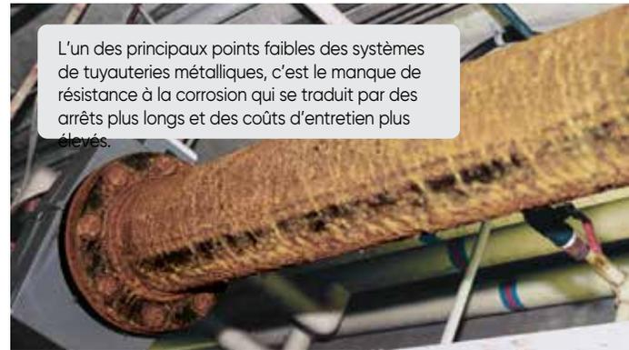
L'un des principaux points faibles des systèmes de tuyauteries métalliques, c'est le manque de résistance à la corrosion qui se traduit par des arrêts plus longs et des coûts d'entretien plus élevés.
