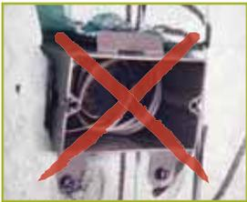
Jusqu'à maintenant, il y a toujours eu très peu de choix concernant les solutions véritablement professionnelles d'installation des boîtes électriques dans les bâtiments construits à l'aide de formes isolantes pour béton (bâtiments FIB). Les boîtes électriques traditionnelles sont pénibles à installer et exigent souvent une
