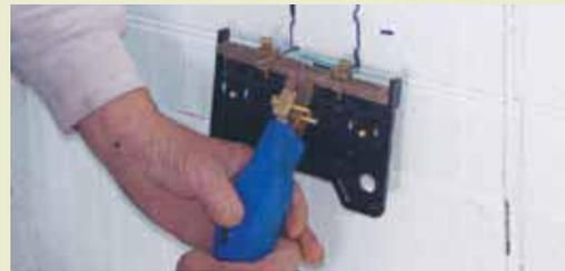
**ÉTAPE 1 :** choisir l'emplacement de votre boîte. À l'aide d'un couteau thermique ou d'un outil de coupe, découper l'ouverture dans la mousse EPS.
