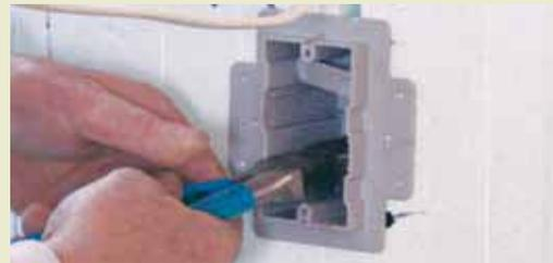
**ÉTAPE 2 :** insérer la boîte INEXO dans cette ouverture et mettre en place les « dents » en poussant jusqu'à ce que l'on entende un « clic » – ce qui indique que la boîte est bien fixée. Lorsque l'on se trouve près d'une attache, il est possible d'utiliser deux des « dents » du côté sans attache et de visser dans l'attache en plastique par les trous pratiqués dans le rebord.
